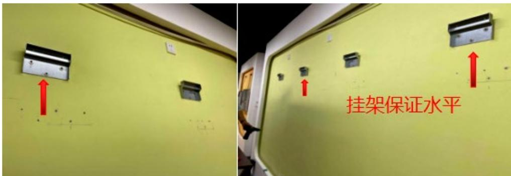
⑥、黑板安装：将一体机（黑板主屏）挂到中间两个挂墙挂钩上，将一体机上的接地线有效接地（接地不良会导致触摸屏异常）；将黑板副屏挂到挂墙挂钩上并用锁附固件固定；
